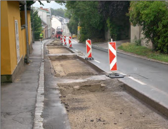
Die erste Bauphase der Sanierung des Schmutz- und Regenwasserkanals in der Johannesstraße wurde beendet. Ende Juli ist der Behelfsasphalt über dem Künettenbereich der bisher neu verlegten Kanalleitungen abgetragen worden.
